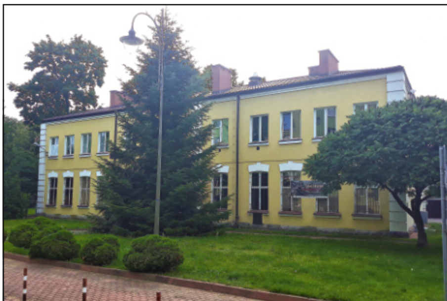
Kwatera oficerów legionowych. Dziś nr 21 z dobudowanym piętrem. (fot. autor)
