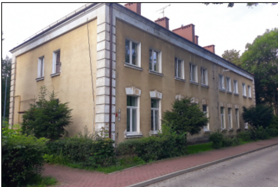
Kwatera oficerów legionowych. Dziś nr 20 z dobudowanym piętrem. (fot. autor)
