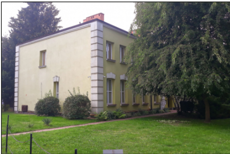
Kwatera oficerów legionowych. Dziś nr 19 z dobudowanym piętrem. (fot. autor)
