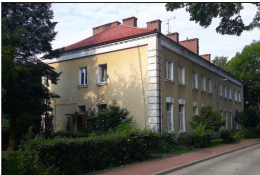
Kwatera oficerów legionowych. Dziś nr 17 z dobudowanym piętrem. (fot. autor)
