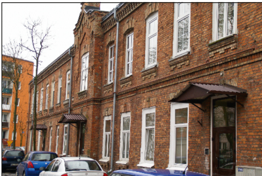
Jeden z budynków przeznaczonych na mieszkania kadry (fot. autor)
