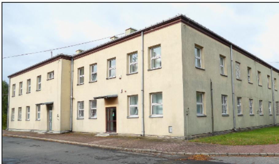
Kwatera ordynansów oficerów legionowych. Dziś na terenie jednostki wojskowej, z dobudowanym piętrem i skrzydłem (fot. M. Jankowski, 9. BWD DG RSZ)
