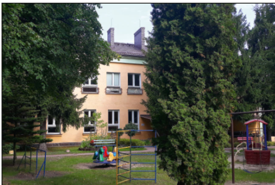
Kwatera oficerów legionowych. Dziś nr 95 z dobudowanym piętrem. (fot. autor)
